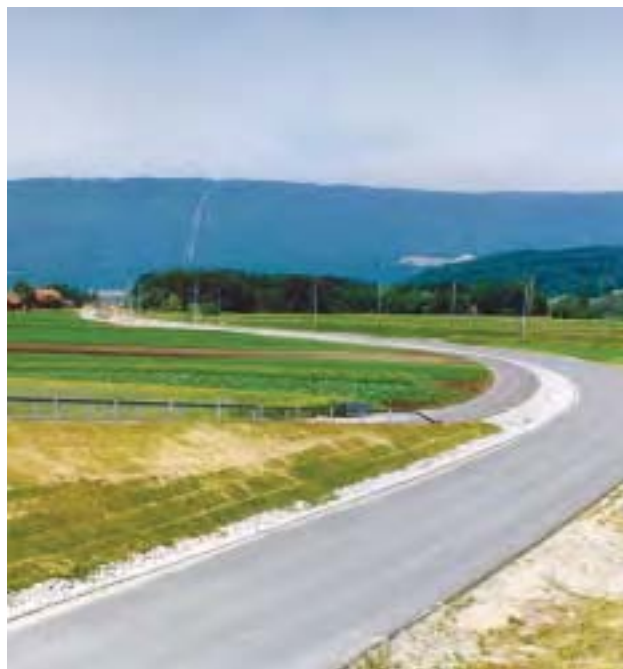
Pertes fonctionnelles dues à l'effet de coupure des nouveaux axes de circulation (T10 près d'Anet)
