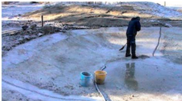
Figure 8. Mise en place du produit d'imperméabilisation du béton. Les niches aménagées au fond du plan d'eau et sur les berges permettent de délimiter les zones refuges lors des entretiens qui seront réalisés.
