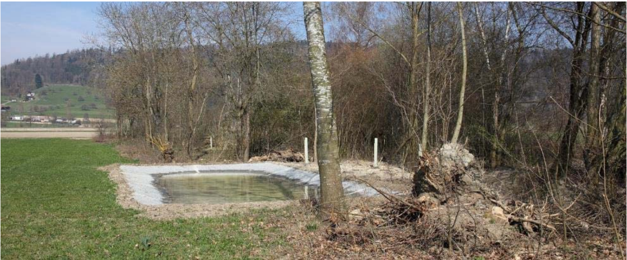
Figure 6. Plan d'eau bétonné sur bâche avec un système de vidange sous l'eau (Jens, BE). Espèce cible : Crapaud calamite.
