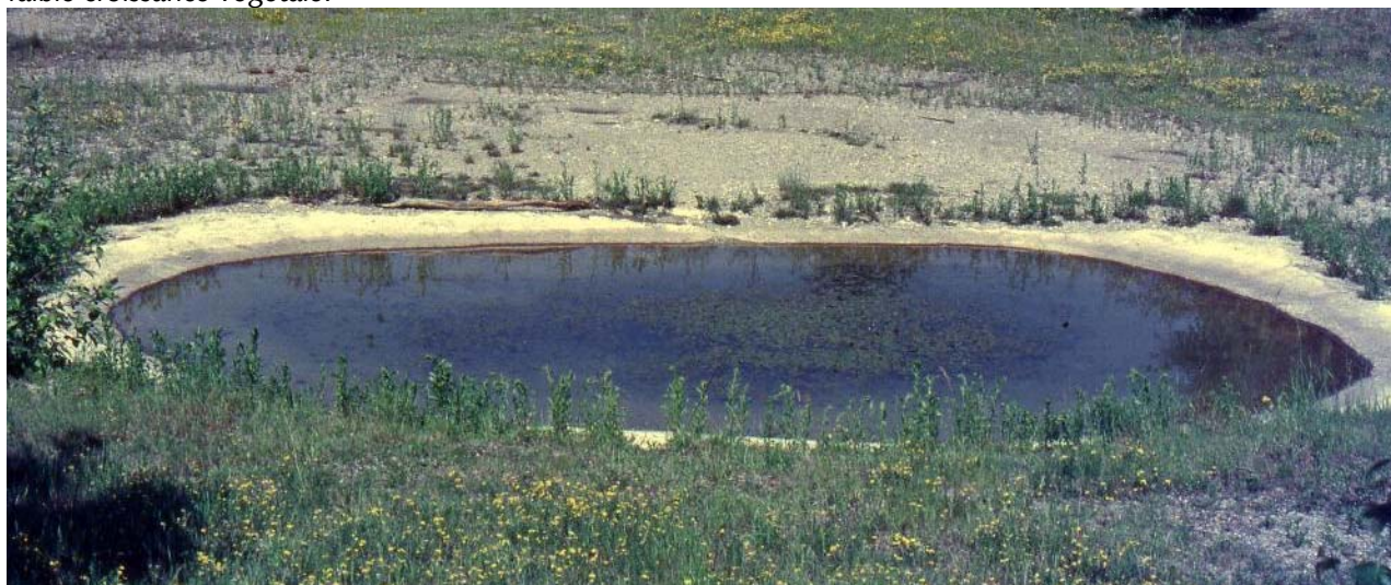
Figure 12. Aménagé il y a plus de 30 ans, ce plan d'eau bétonné (Schwarzenburg, BE) est encore fonctionnel, et toujours aussi facile à entretenir.
