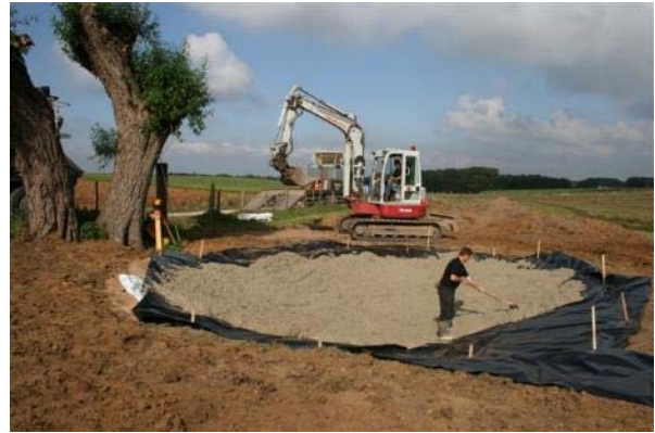
Figure 3. Mise en place d'une fine couche de béton sur une bâche d'étanchéification (Pays-Bas). Espèce cible : Crapaud accoucheur.
