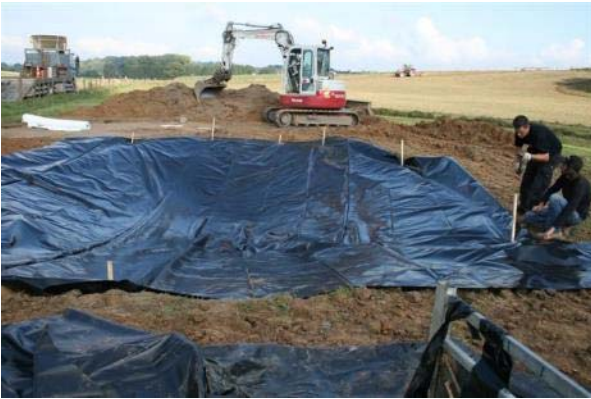
Figure 3. Mise en place d'une fine couche de béton sur une bâche d'étanchéification (Pays-Bas). Espèce cible : Crapaud accoucheur.
