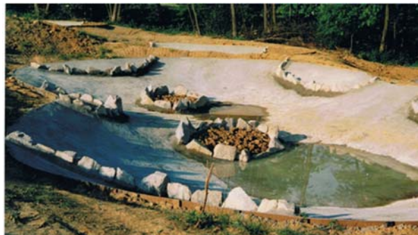
Figure 8. Mise en place du produit d'imperméabilisation du béton. Les niches aménagées au fond du plan d'eau et sur les berges permettent de délimiter les zones refuges lors des entretiens qui seront réalisés.
