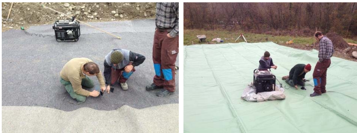
Figure 11. Mise en place de la bonde de vidange : 1. Découpage du géotextile de protection et 2. Soudure de la bonde sur la bâche d'étanchéité (Les Raclerets, GE)
