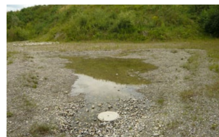
Illustration 2. Lorsque les autres options ne sont pas réalistes, une imperméabilisation artificielle est une bonne solution pour recréer des plans d'eau temporaires. Les différentes épaisseurs de chaque couche ont leur importance.
