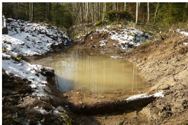
Illustration 1. Décapage dans une dépression naturellement humide et mise en place d'un barrage le long d'un fossé forestier élargi.
