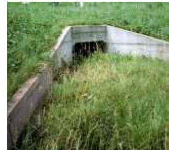
Abbildung 8: Amphibienpassage in Kastenform (VSS-Norm 40 699a)
