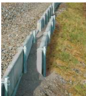
Abbildung 12: Beispiel Einbau einer Böschungssicherung mit vorgefertigtem Element
