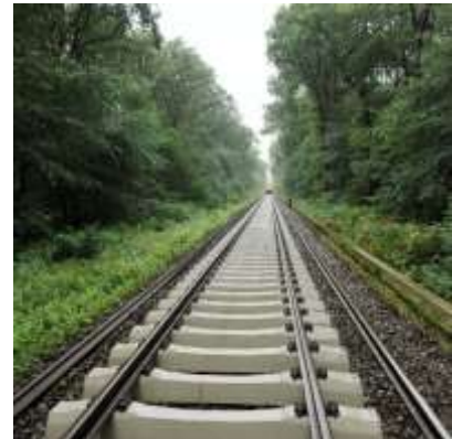
Abbildung 11: Einbau Gleis unmittelbar vor dem Stopfen. Idealerweise wird ein Abstand unterhalb der Schienenunterseite beibehalten ( www.plassertheurer.com )
